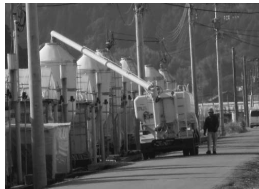
貯蔵タンクへの燃料の投入
