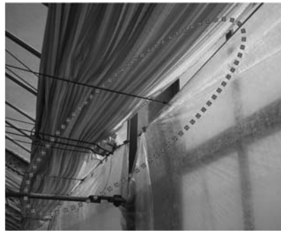
天井カーテンと側面カーテンのつなぎ目
