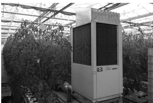
地下水熱源ヒートポンプ（室内機）
