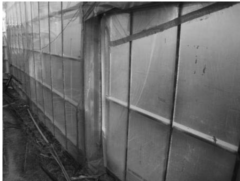
外張被覆の隙間を目張り
