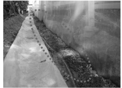
カーテン裾部の固定（土盛り）
