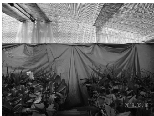
温室北面へ断熱資材を固定張り
