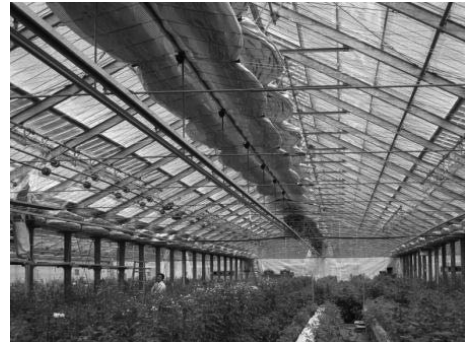
フッ素系硬質フィルムによる固定2重化
