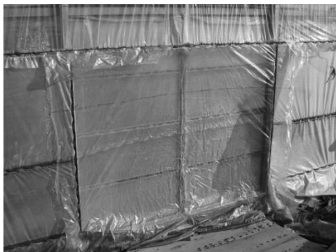
使用しない出入口を目張り
