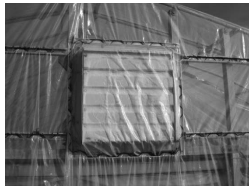
換気扇のシャッターを目張り
