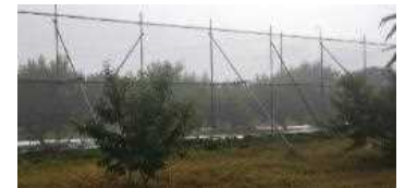
防風ネットの設置
